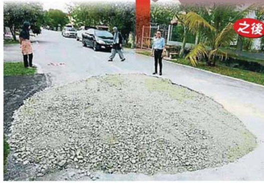
经修补完毕的排污管后已铺上沙石。图为蔡颯颯正观察已做好填土工程的大洞是否有下陷迹象。
