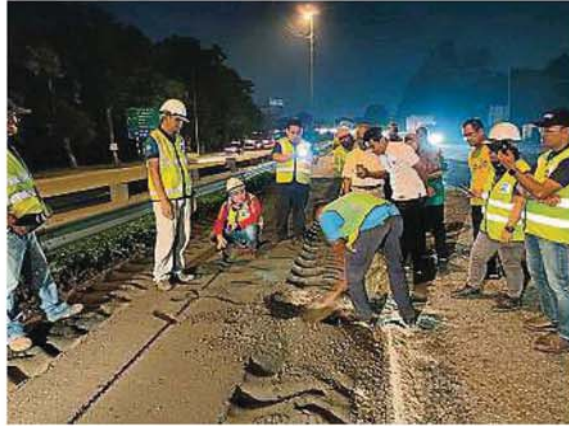
阿兹米占（右三）亲自下场视察就地冷再生技术的运用。
