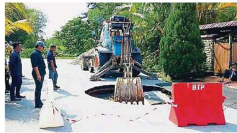
泥, 进行排污管的检查工作。英达丽水公司派员手挖开地底的黄
