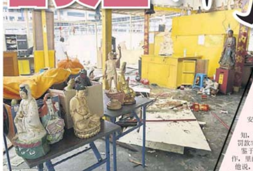
■普贤堂已经被拆除，剩下建筑物架构。
